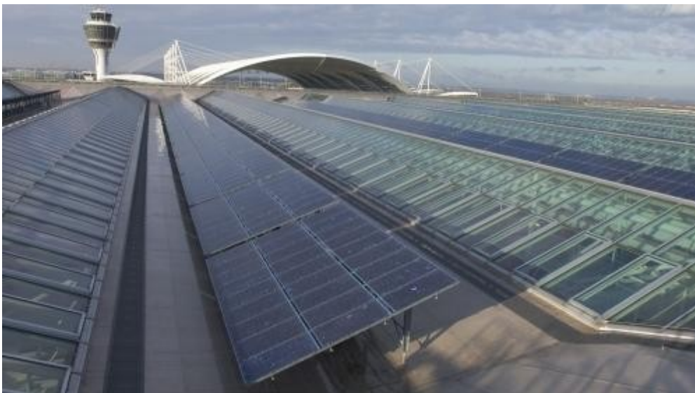
Imagine a structurii de acoperire a terminalului 2 – panouri foto-voltaice și luminatoare zenitale
